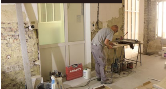
Les travaux de rénovation réalisés à la Boutique Solidarité de Valenciennes.
